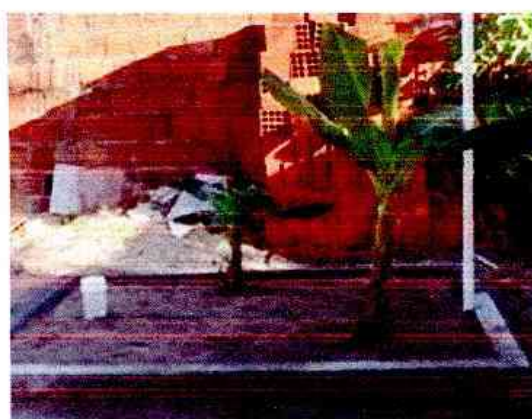
Figura 110 – Tanque de evapotranspiração
