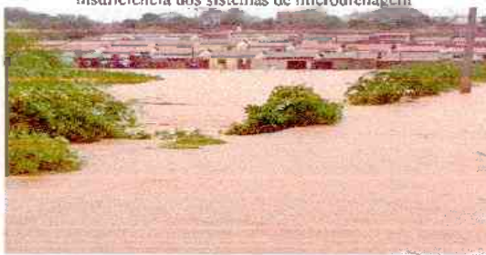
Bairro popular do PMCMV construído dentro da área de vazante do riacho
