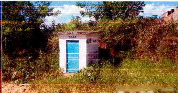
Elevatória 04 – Alto do Cruzeiro
