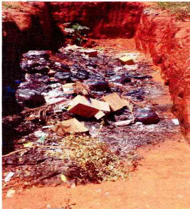
Figura 79 – Vala comum que recebia os RSS na área de disposição final de Igaporã
