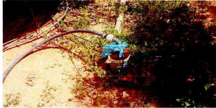
Figura 43 – Poço Artesiano locado para atender a Comunidade de Passagem da Pedra
