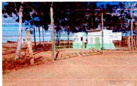
Portão de acesso e guarita – atualmente (jul/19)
