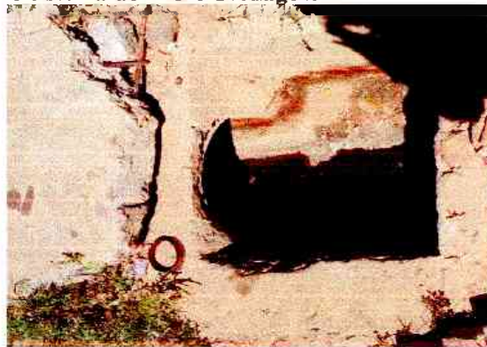
Esgotos na micro drenagem da Rua Hélio A. da Silva
