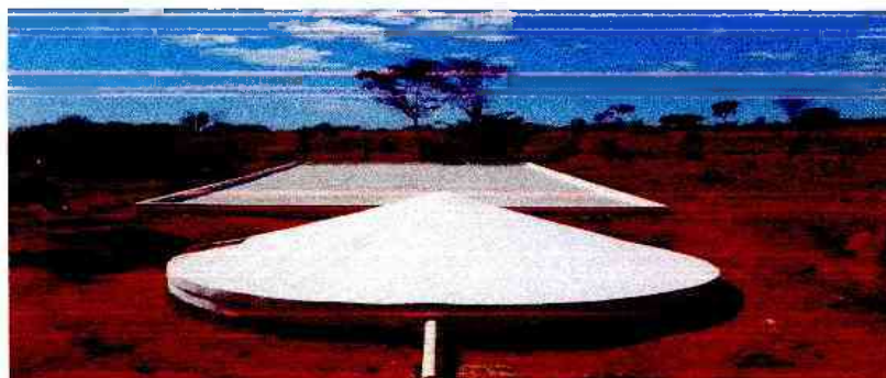
Figura 48 – Modelo de tecnologia da cisterna-calçadão do MDS
