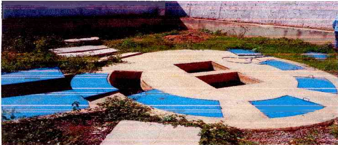
Figura 59 – Poço da EEE01, com diâmetro de 4,50 metros
