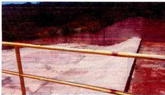
Vertedouro totalmente seco Fonte: PISA, 2019.
