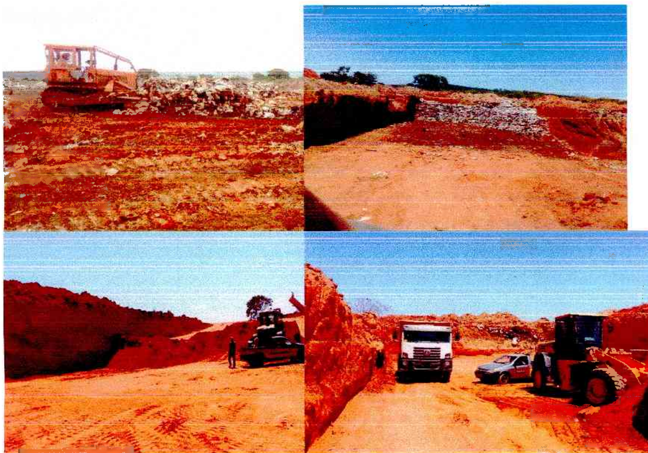
Figura 131 – Remediação da área de disposição final de resíduos sólidos urbanos – Igaporã/BA
