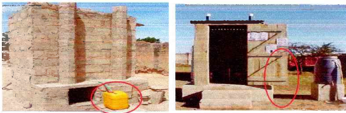
Figura 114 – Bombonas de armazenamento temporário (esquerda) e de estocagem (direita) em sanitário com separação de urina implantadas em países da África
