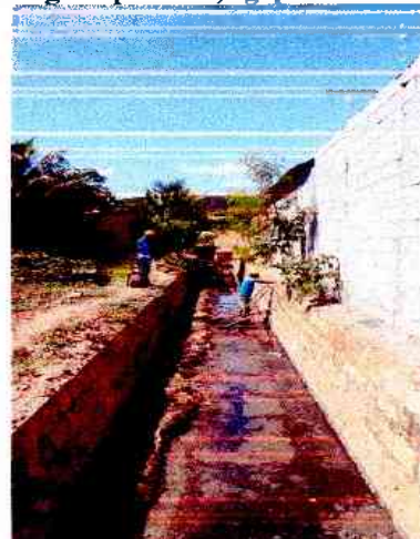
Canal da Rua Sergipe
