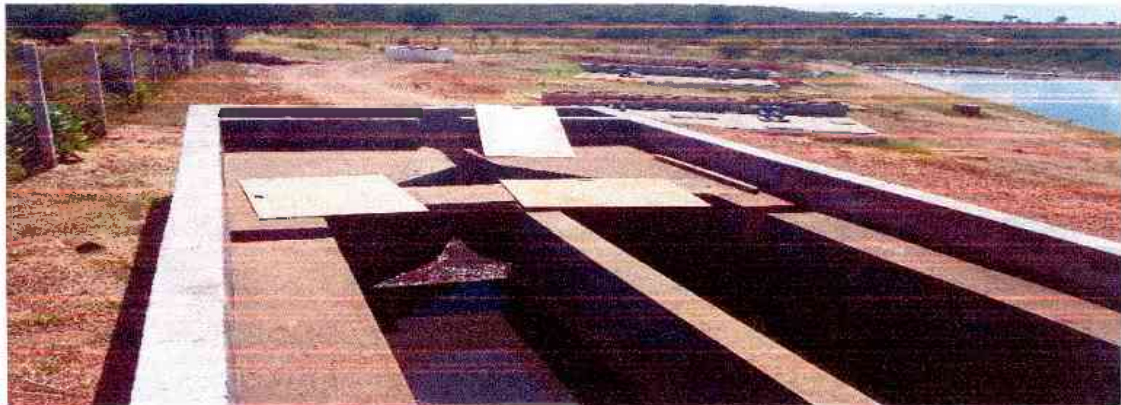
Figura 62 – Sistema de calha Parshall e Caixa de Areia da ETE do SAAE
