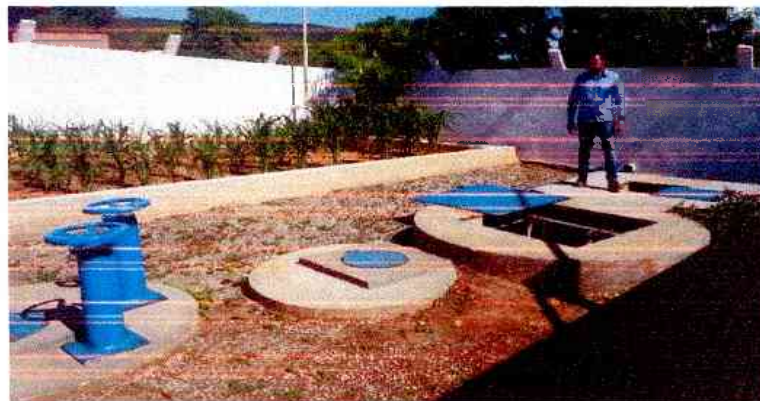
Figura 60 – Poço da EEE02, com diâmetro de 2,20 metros
